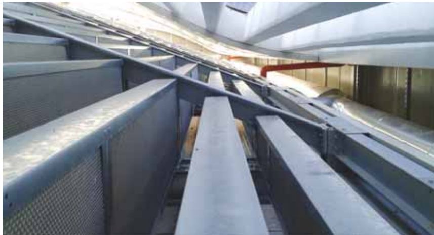
Baffles acoustiques SA/LF Type d'application sur la structure métallique d'un bâtiment pour installations technologiques
