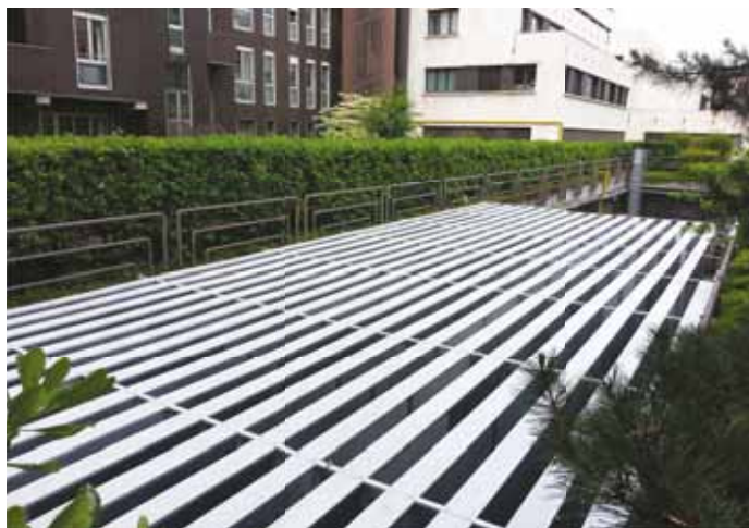
Baffles acoustiques SA/LF Type d'application sur une charpente métallique réalisée sur une construction en béton armé
