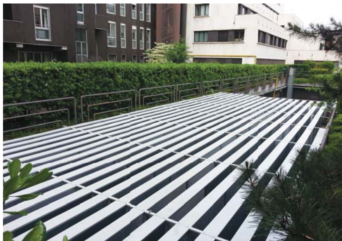
Setti afonici SA/LF Tipo di applicazione su orditura metallica predisposta sopra una costruzione in cemento armato
